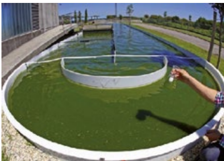
Figura 1: Planta de crecimiento de microalgas ubicada en la EDAR de Guillarei.
