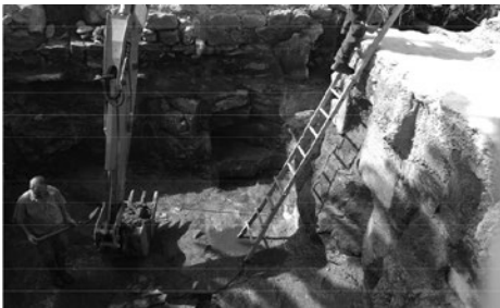
Figura 3: Detalle de las labores de vaciado y limpieza en el Pozo Mar.
