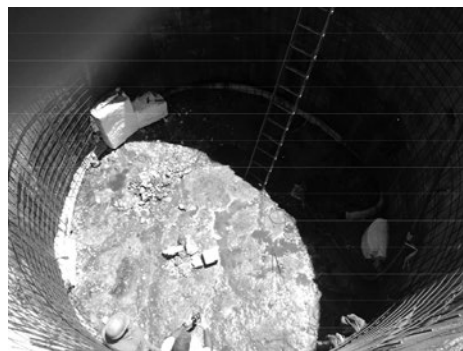
Figura 4: Preparación de cajado en zona de surgencia (Pozo Capilla).
