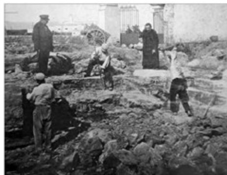
Figura 4: Fotografía de los trabajos de excavación realizados en Caldes de Malavella a principios del siglo XX (54).
