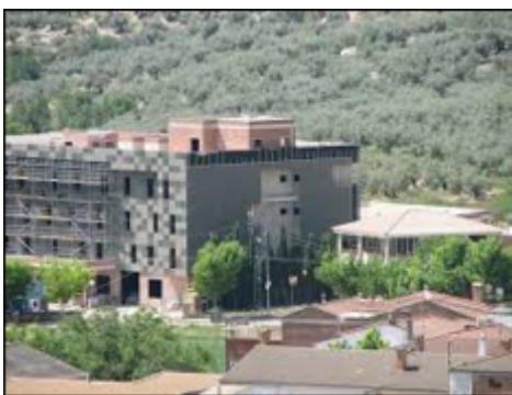
Figura 3: Balneario de Frailes (en construcción).
