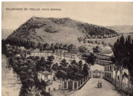
Figura 1: Vista general del antiguo balneario de Trillo
