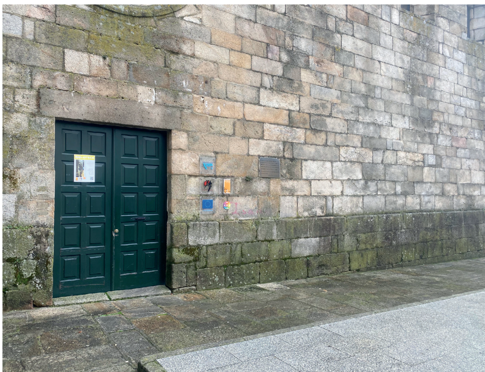
Figura 5. Situación da placa na fachada
