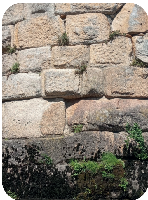
Detalles das cepas e perpiaños da Ponte Vella de Ourense (fotografías do autor)
