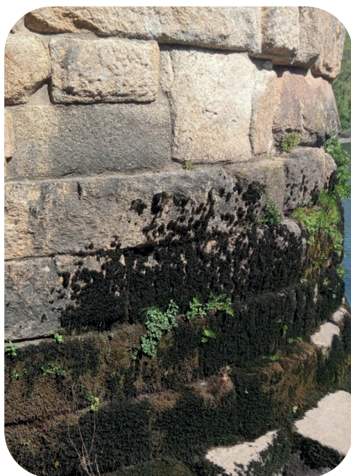
Detalles das cepas e perpiaños da Ponte Vella de Ourense (fotografías do autor)
