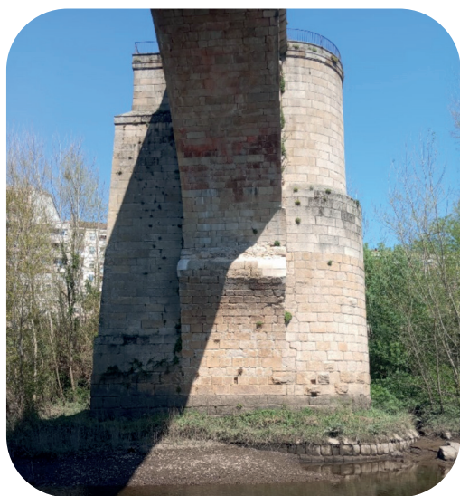
Detalles das cepas e perpiaños da Ponte Vella de Ourense (fotografías do autor)
