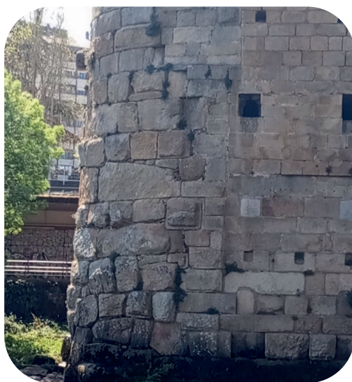
Detalles das cepas e perpiaños da Ponte Vella de Ourense (fotografías do autor)
